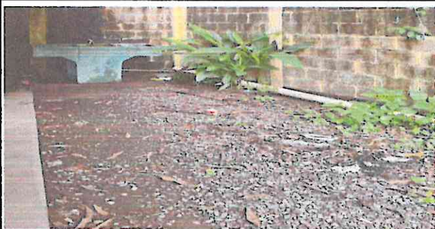
Foto 11: Reparación de drenajes
