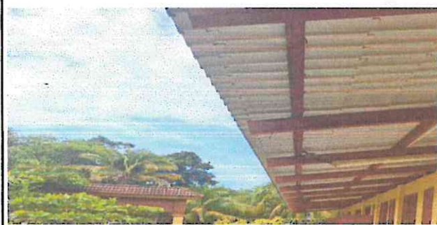
Foto 5: Sustrucción de canal de metal sujeto con perfil de metal en patio
