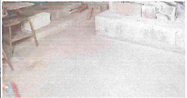
Foto 4: Sustrucción de piso de concreto por piso cerámico antideslizante en cocina
