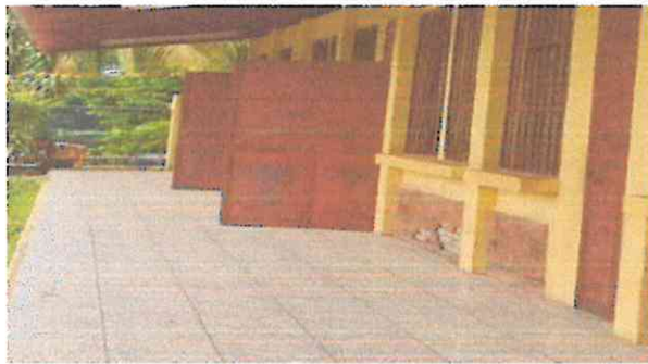
Foto 3: Mantenimiento de puertas de metal lijado y pintura en aulas
