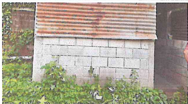
Foto 7: Reparación de banqueta de concreto en cocina
