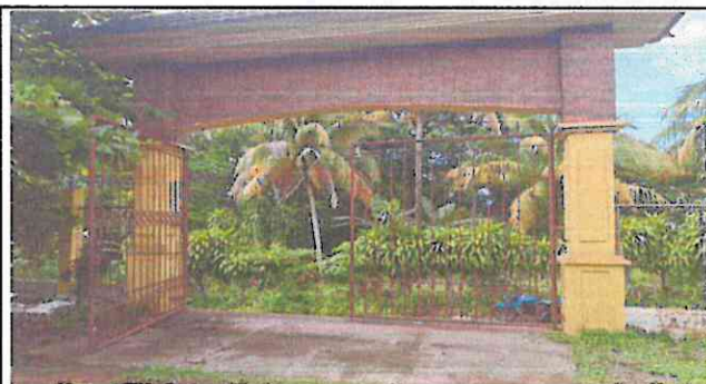
Foto 9: Mantenimiento de porton de metal ( lijado y pintura)
